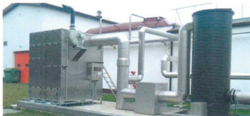
Rysunek 7. Stacja dezodoryzacji powietrza nr 2 [zdjęcie: Aquanet S.A. „Wewnętrzny audyt odorowy na terenie Oczyszczalni Ścieków w Rudzie Bugaj” z dn. 30.06.2016]
