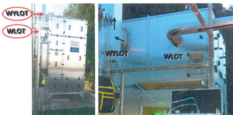
Rysunek 38. Instalacja dezodoryzująca nr 1 [zdjęcia: PZJP]
