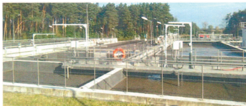
Rysunek 13. Blok komór biologicznych [zdjęcie: PZJP]
