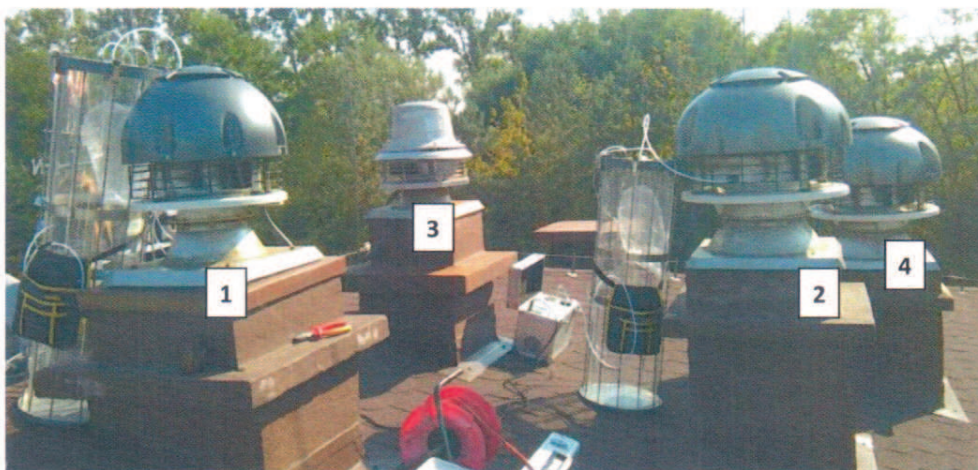
Rysunek 41. Wentylatory wyciągowe zlokalizowane na dachu budynku krat [zdjęcie: PZJP]
