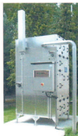
Rysunek 10. Stacja dezodoryzacji powietrza nr 1 [zdjęcie: PGKiM]
