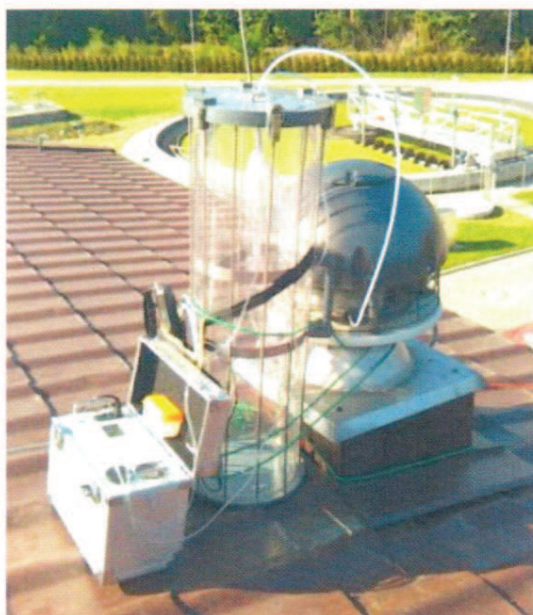
Rysunek 43. Pobieranie próbek zanieczyszczonego powietrza emitowanego z budynku stacji zagęszczania i odwadniania osadu [zdjęcie: PZJP]
