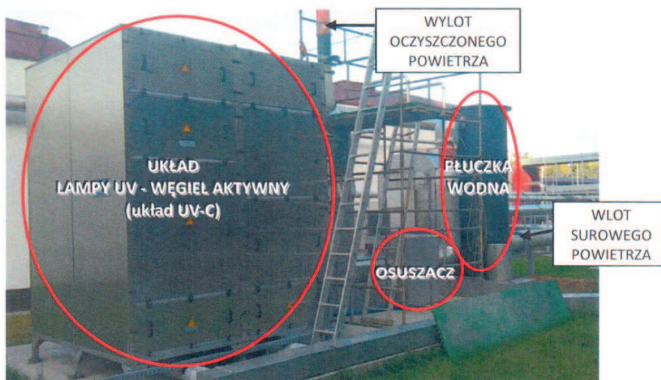
Rysunek 26. Elementy instalacji dezodoryzującej nr 2 [zdjęcie: PZJP]
