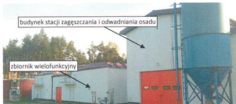
Rysunek 5. Zbiornik wielofunkcyjny i budynek stacji zagęszczania i odwadniania osadu [zdjęcie: PZJP]
